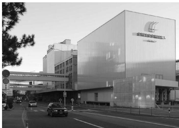
Neues Swissmill-Hochregallager (Stahl-/Glaskonstruktion) mit Solaranlage auf dem Dach.
