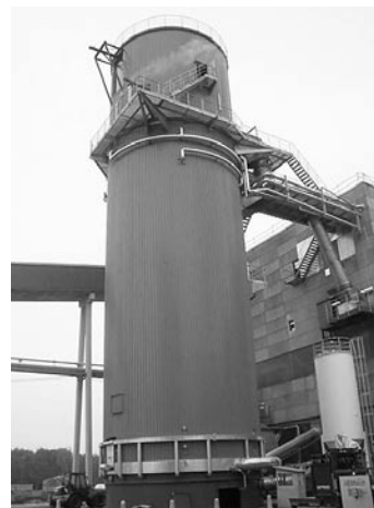
Nouvelle tour d'extraction à l'usine de Frauenfeld.
